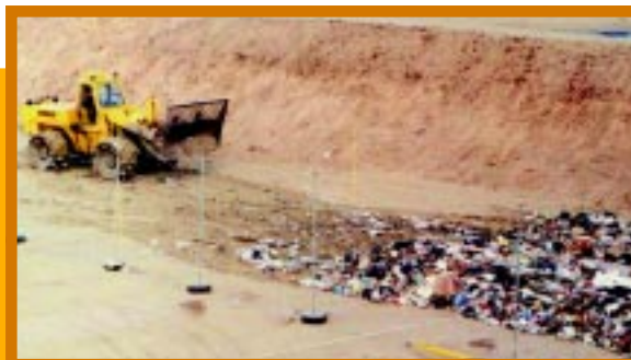
Acondicionamiento de residuos en el relleno sanitario de Las Rosas, departamento de Maldonado
