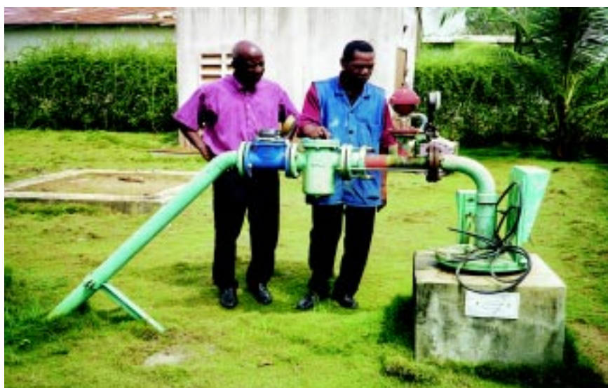
Personal de SODECI inspecciona la fundación del equipo de bombeo en Songon Kassemble, Costa de Marfil.
